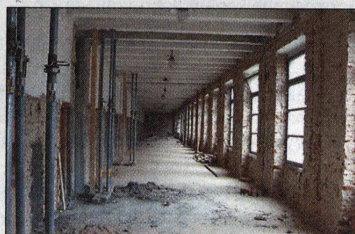
SNÍMKY z interiéru rekonstrukce industriální budovy v Heleníně.
